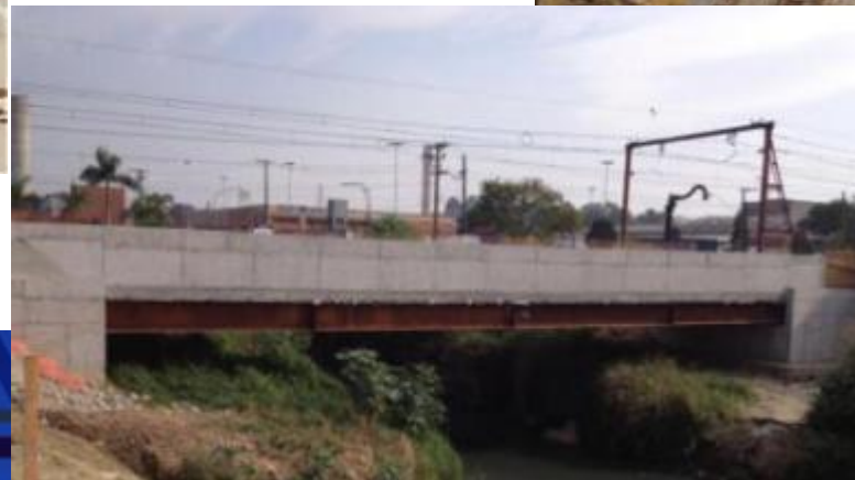
Ponte Guaió - 31,5 m
