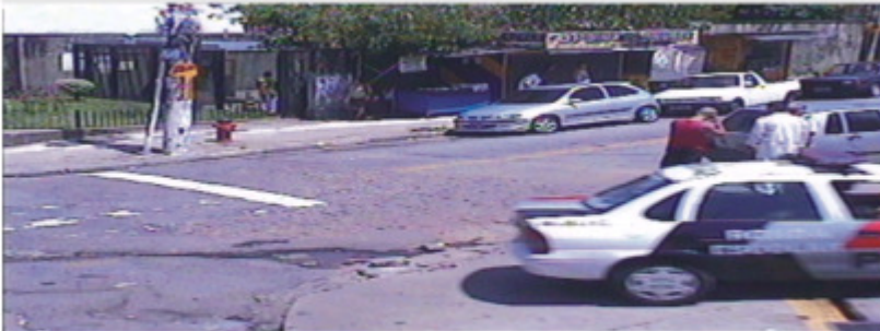
Qualidade da Pavimentação e Drenagem
