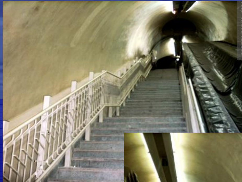
Estação Vila Madalena
