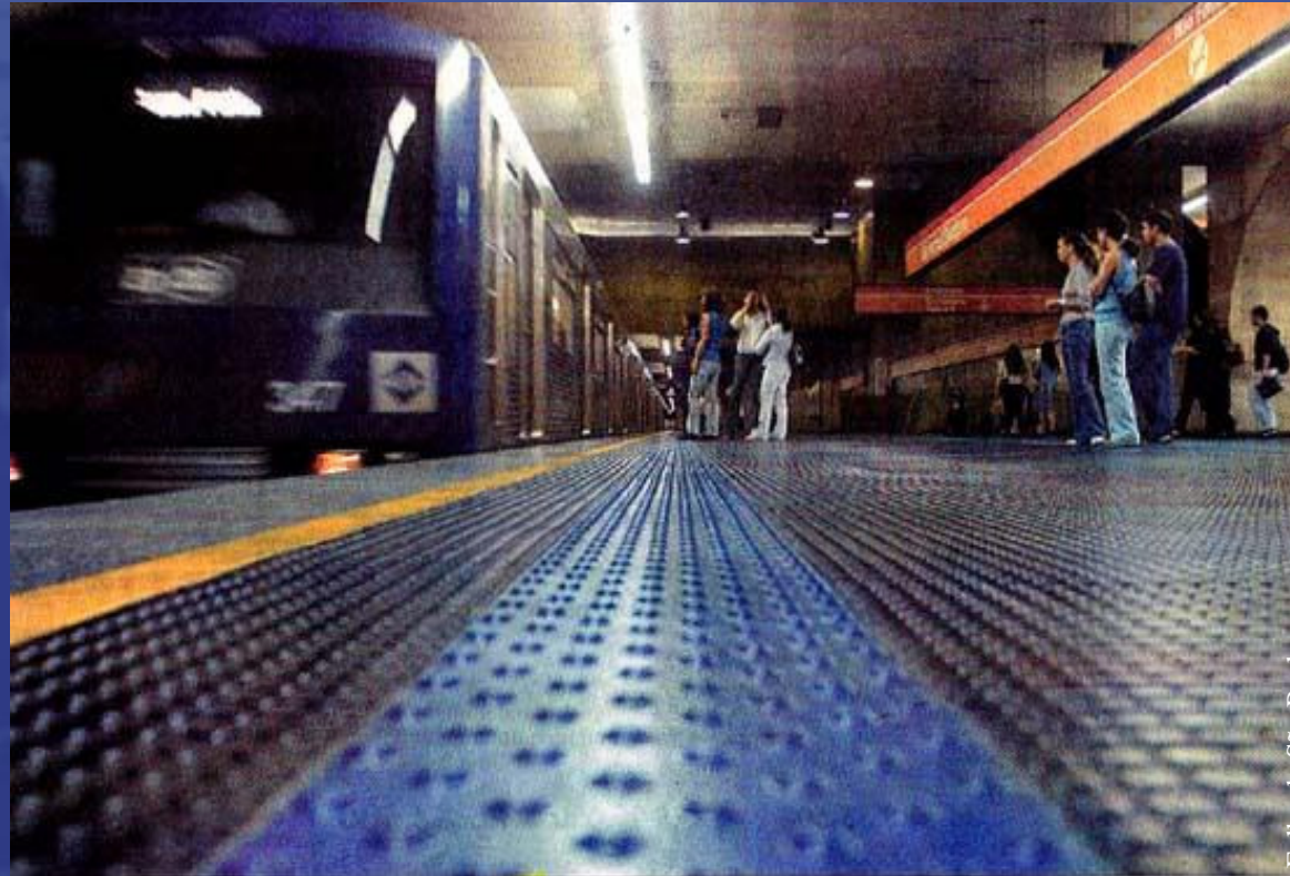
Faixa Tátil na Borda da Plataforma
