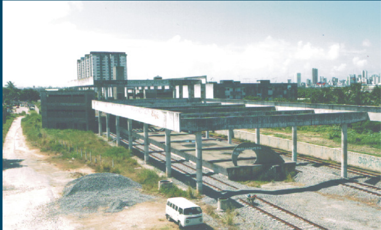
ESTAÇÃO TANCREDO NEVES
