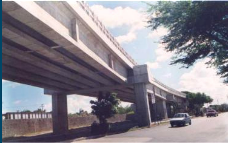
ELEVADO FERROVIÁRIO - AV. SUL
