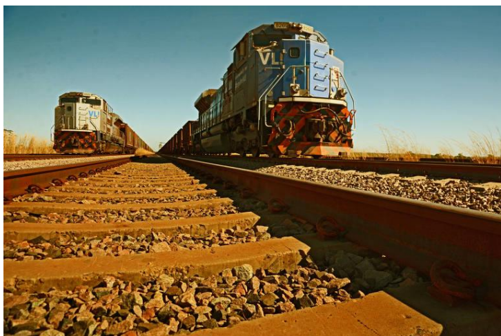
Ferrovia Norte-Sul tem estrutura para 9 milhões de toneladas de grãos /Karime Xavier/Folhapress
