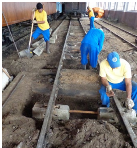
Substituição dos dormentes de madeira visa otimizar a vida útil desse item
