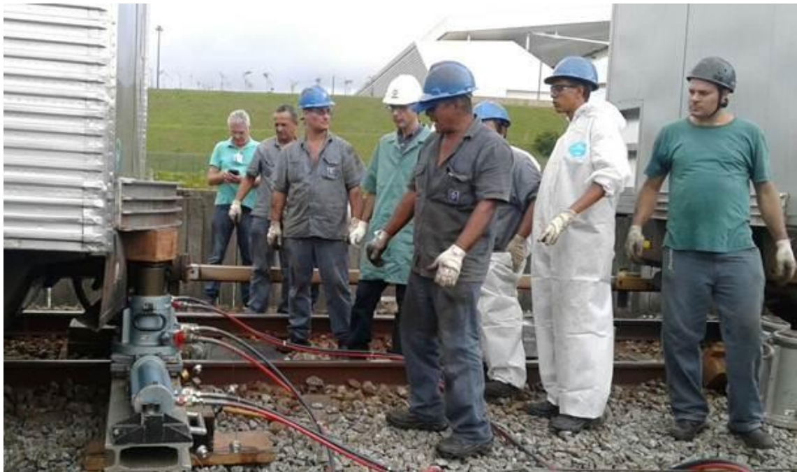
Equipe da manutenção trabalhando durante a ocorrência.
