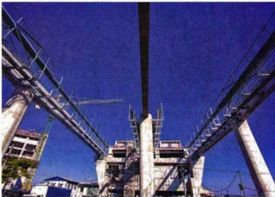
Cada viga-guia de concreto instalada pesa 70 toneladas
