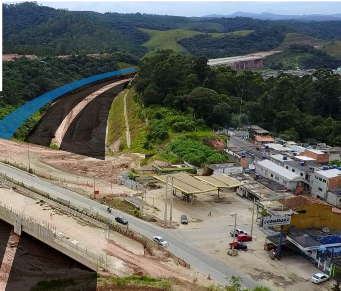
OAE 602 sobre a Estrada Guarulhos – Nazaré
