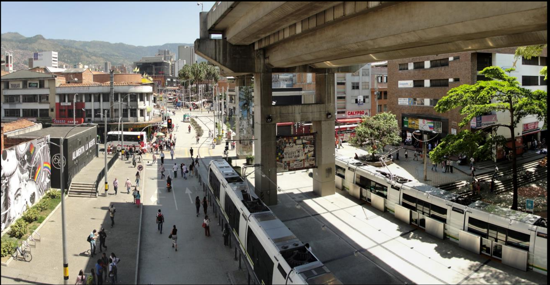
Estación San Antonio Pasarela de ingreso al sistema Metro Línea A.
