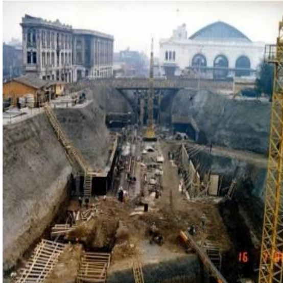
Línea 2: Década de los 80 Sector Estación Puente Cal y Canto
