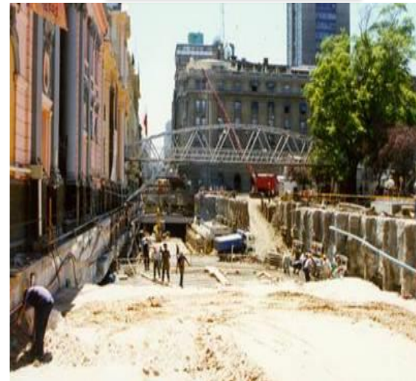
Línea 5. Década de los 90 Estación Plaza de Armas
