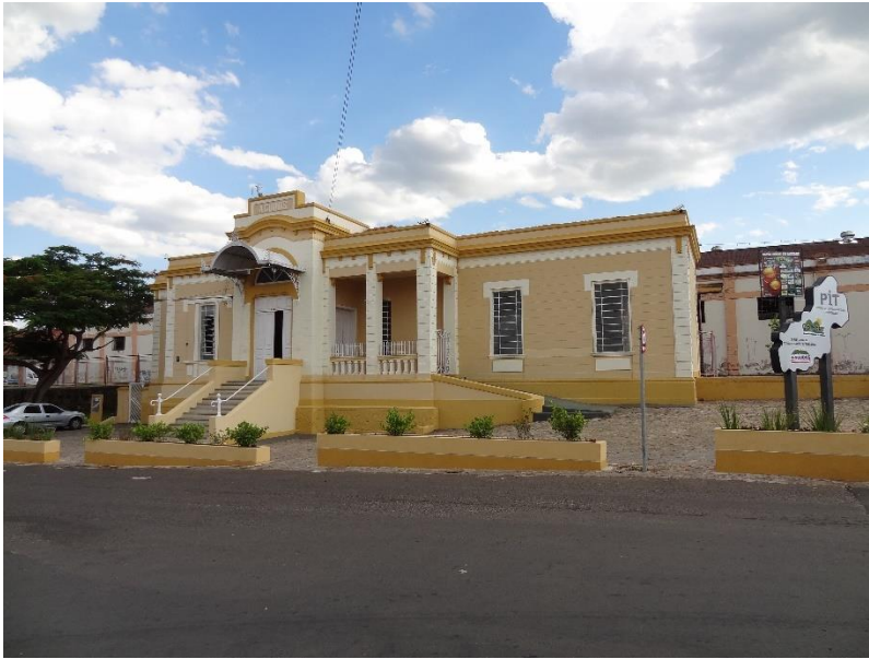
Figura 15 – Estação de Agudos.
