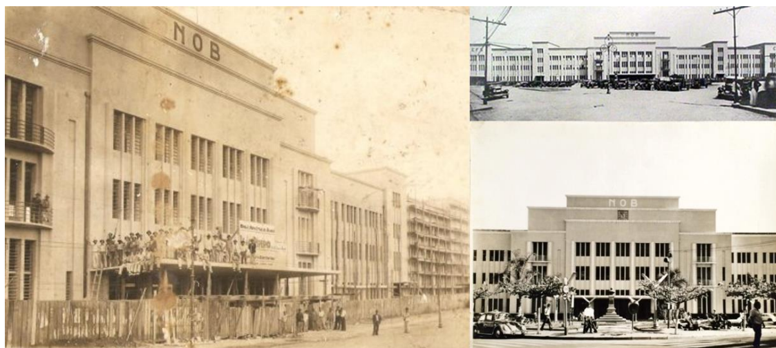
Figura 4 – Estação Central de Bauri.
