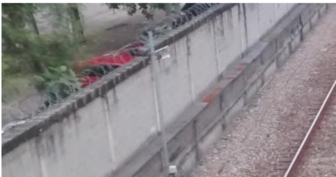
Figura 5 - Bandeamento de cabos com tampa.
