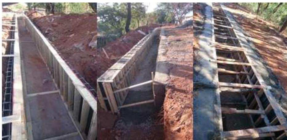
**Figura 14 - Base concretada, com fôrmas internas posicionadas e posterior concretagem das paredes**
