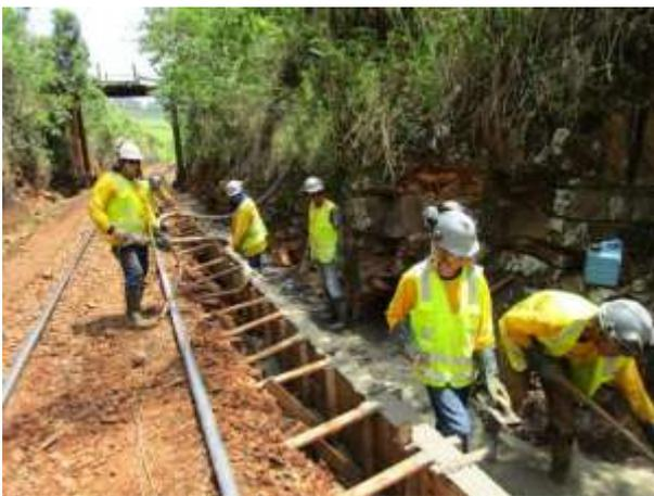
**Figura 19 - Concretagem de canaleta no Km 182 ZCB.ZTD (Portex - Out/15)**
