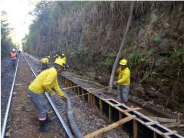
**Figura 17 - Concretagem de canaleta - Km 472 ZUB.ZQQ (RCA - Jul/2016)**
