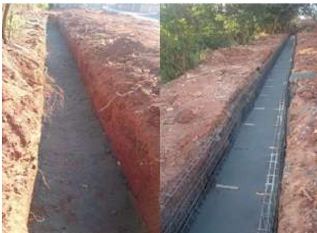
**Figura 13 - Vala escavada, com base regularizada e armadura posicionada**
