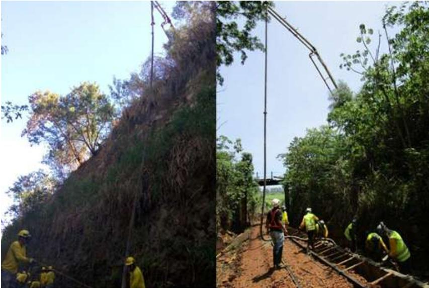
**Figura 18 - Bomba lança posicionada na crista do corte (Km 472 e Km 182) – Centro Sudeste**
