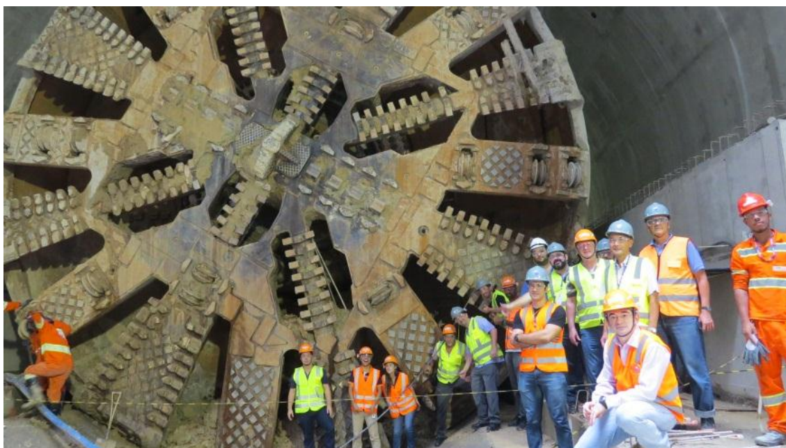
Figura 8 - Vista técnica à tuneladora da Linha 5 - Lilás.
