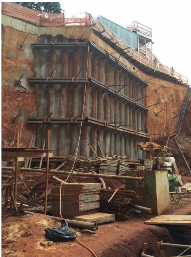
Figura 9: Escavação do subsolo do empreendimento
