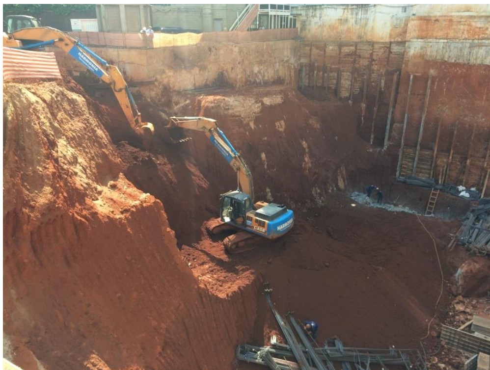
Figura 8: Escavação do subsolo do empreendimento
