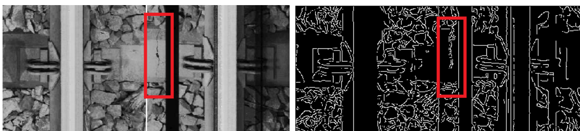
Figura 13 – Defeito em dormente de aço
