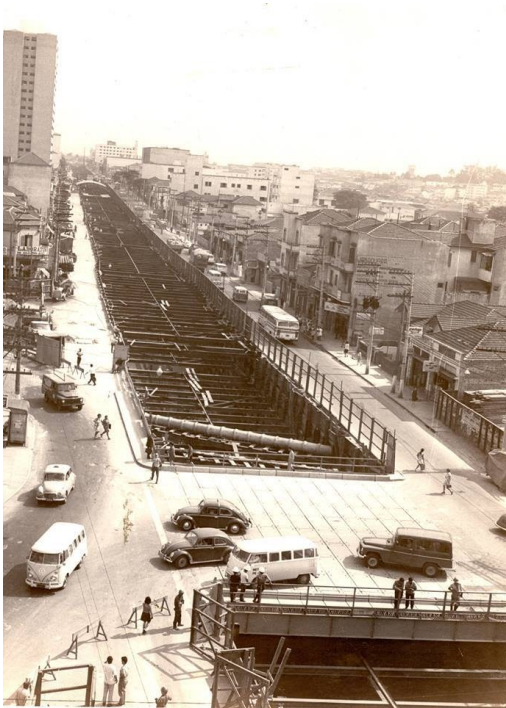
Figura 10 - Obras da Linha 1 – Túnel de via executado pelo método construtivo VCA; Av. Jabaquara esquina com Rua Carneiro da Cunha
