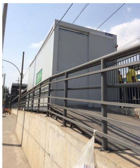
Figura 13 – Container de catracas temporário na plataforma 2 com rampa de acesso
