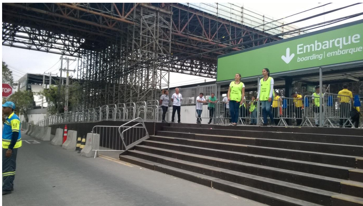
Figura 23 – Estrutura temporária para embarque na SuperVia
