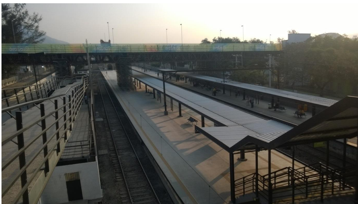
Figura 16 – Passarela de Transposição (temporária) construída pela prefeitura
