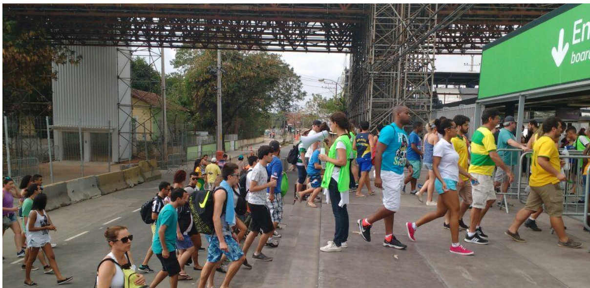
Figura 25 – Estrutura temporária para embarque na estação Magalhães Bastos
