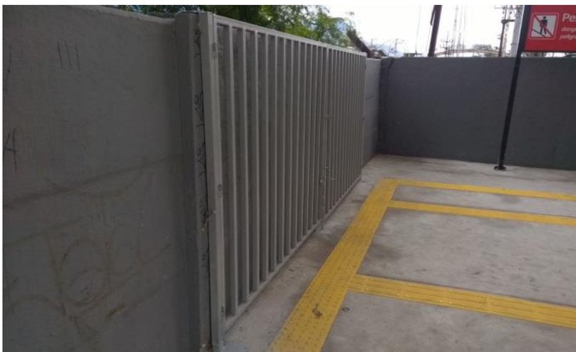
Figura 11 – Local onde a abertura foi realizada no muro da estação Magalhães Bastos
