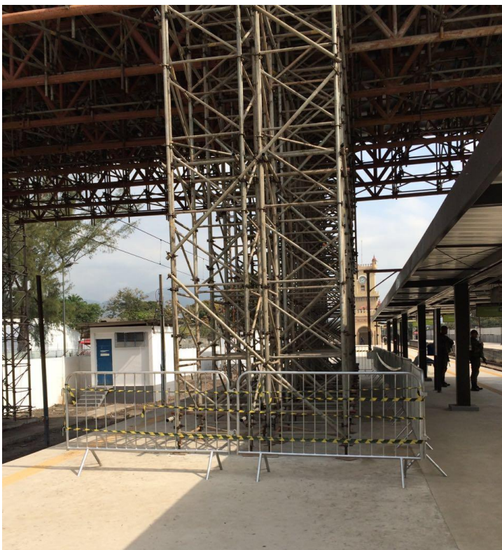
Figura 17 – Pilar da passarela de transposição sobre a plataforma da SuperVia
