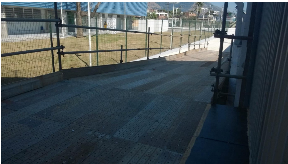
Figura 12 – Rampa temporária para desembarque na estação Magalhães Bastos
