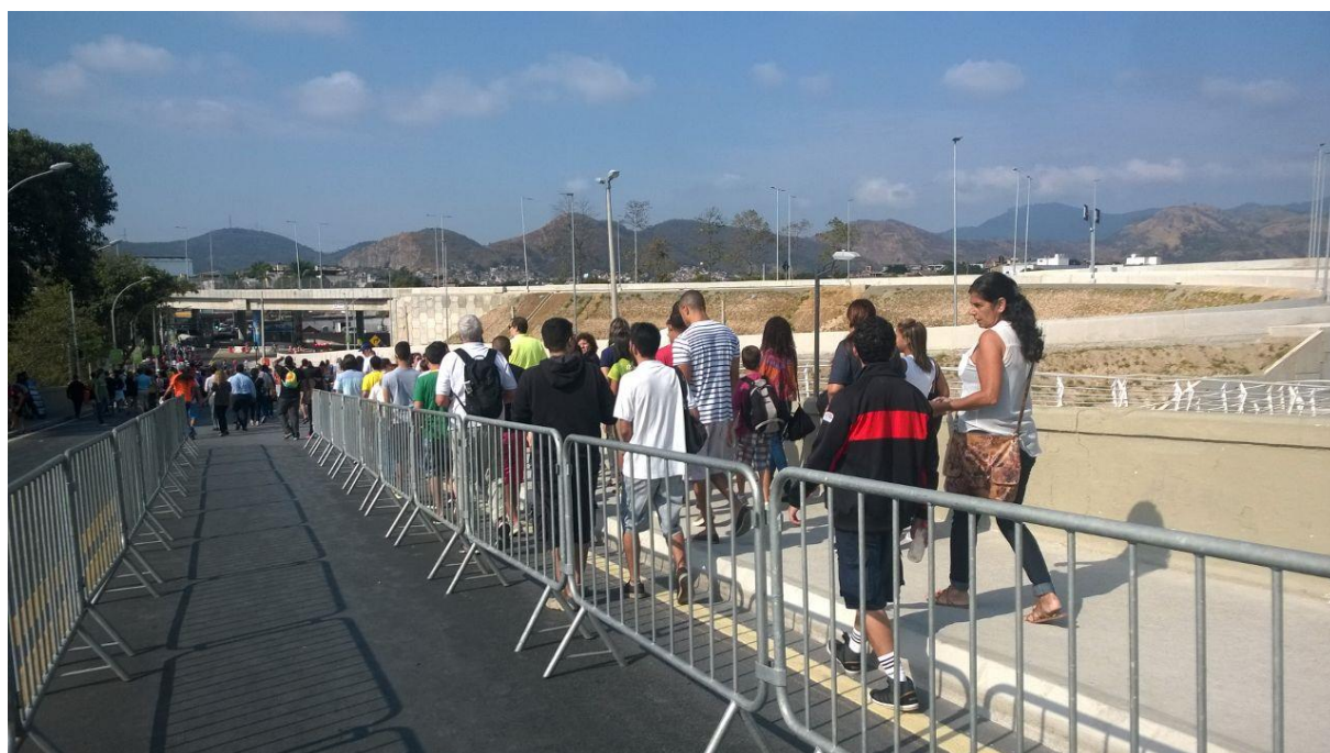
Figura 8 – Viaduto de Magalhães Bastos fechado para carros e separação de fluxos
