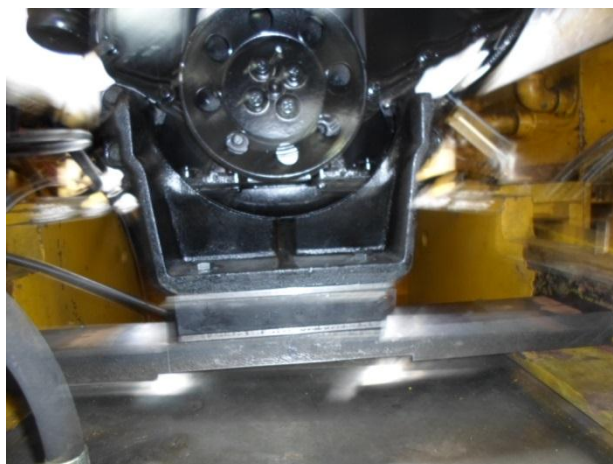
Figura 7 – Alteração no suporte de fixação do motor a diesel
