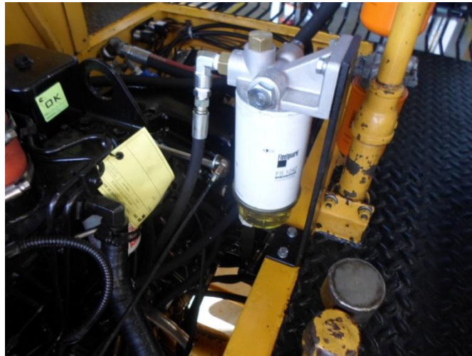
Figura 20 – Pré-filtro separador de água
