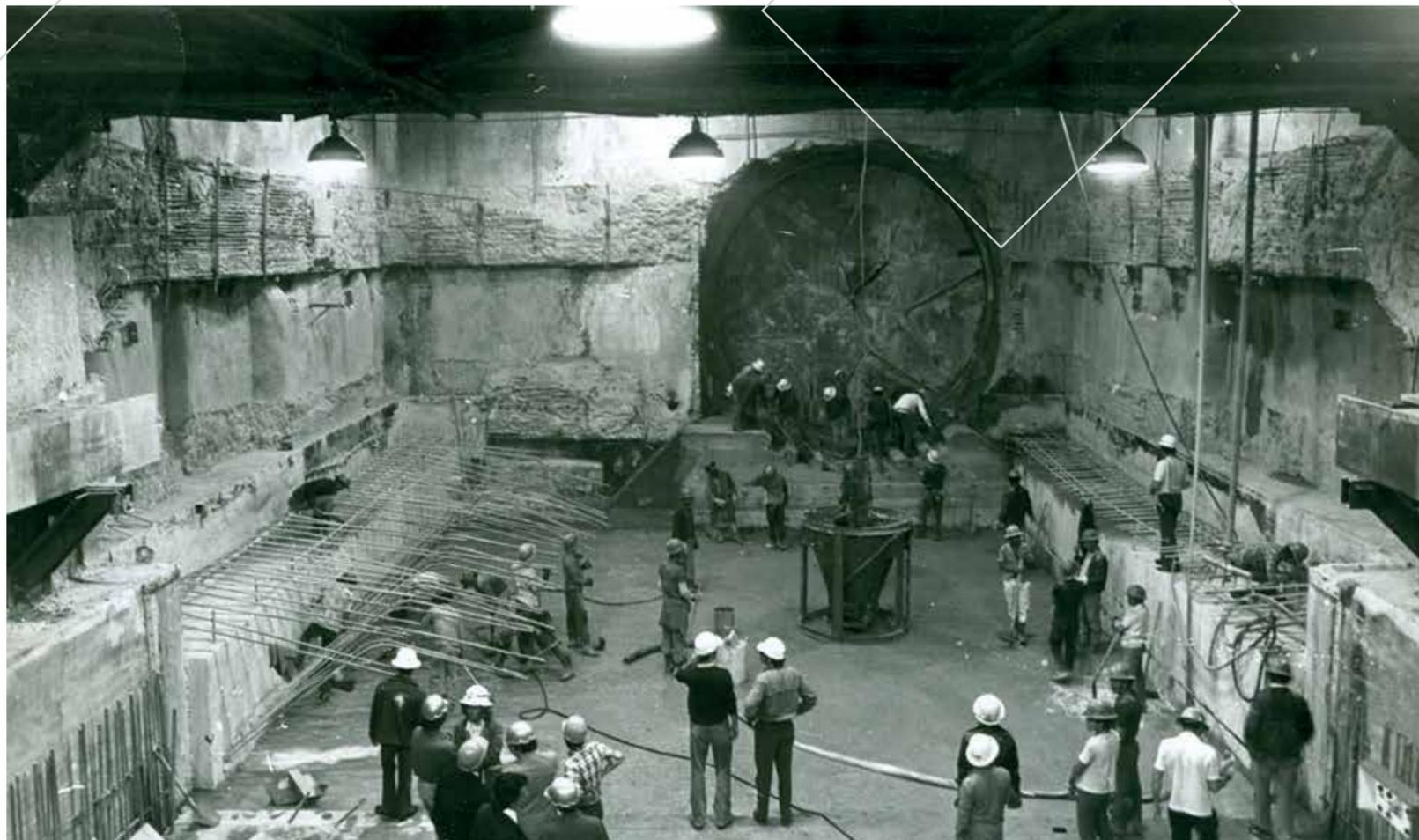
Vazamento do túnel shield chegando ao corpo principal da estação
