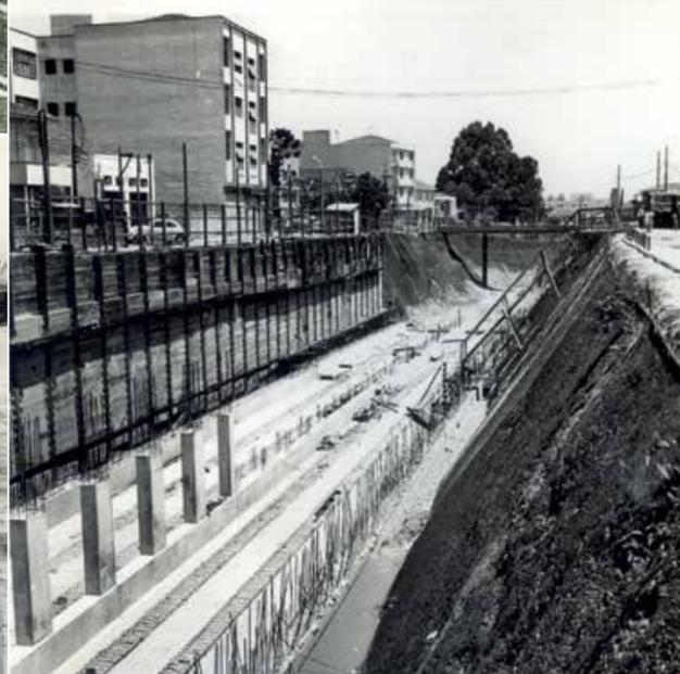
Obras realizadas através do método cut and cover, ou vala aberta, uma novidade que foi colocada em prática pela engenharia do Metrô
