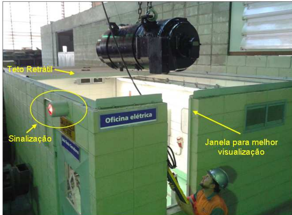
Movimentação de Gerador para o interior da Sala de Testes por teto retrátil
