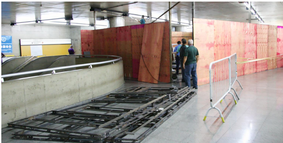
Figura 9 – Início da montagem na Estação Sé
