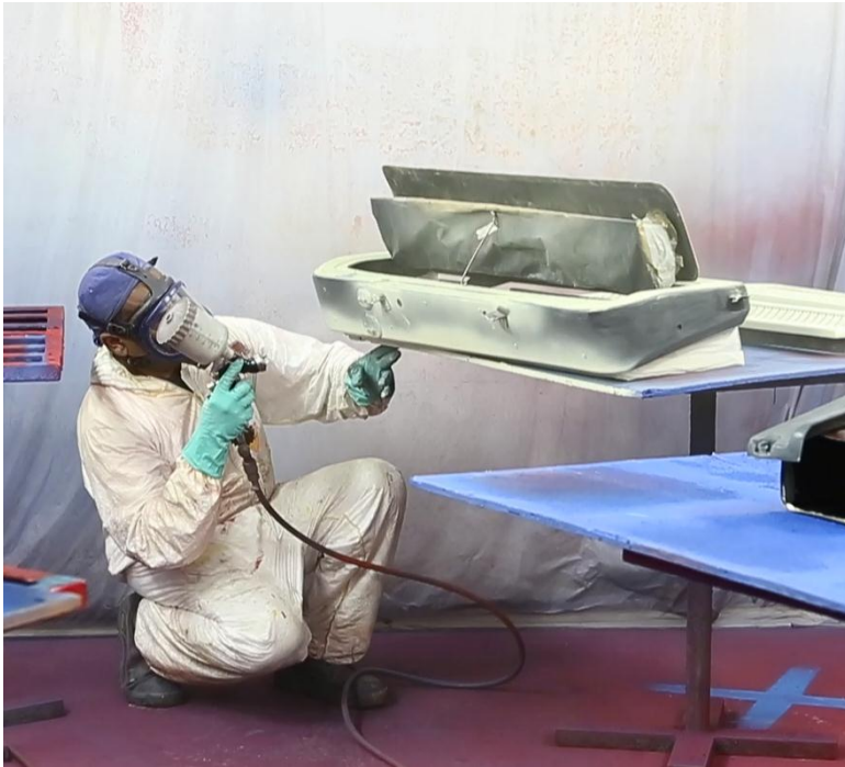
Figura 5 – Reparo de peças do trem A35 na Oficina de Pintura
