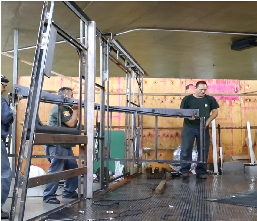
Figura 11 – Montagem da lateral
