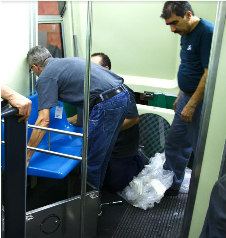
Figura 14 – Montagem do salão
