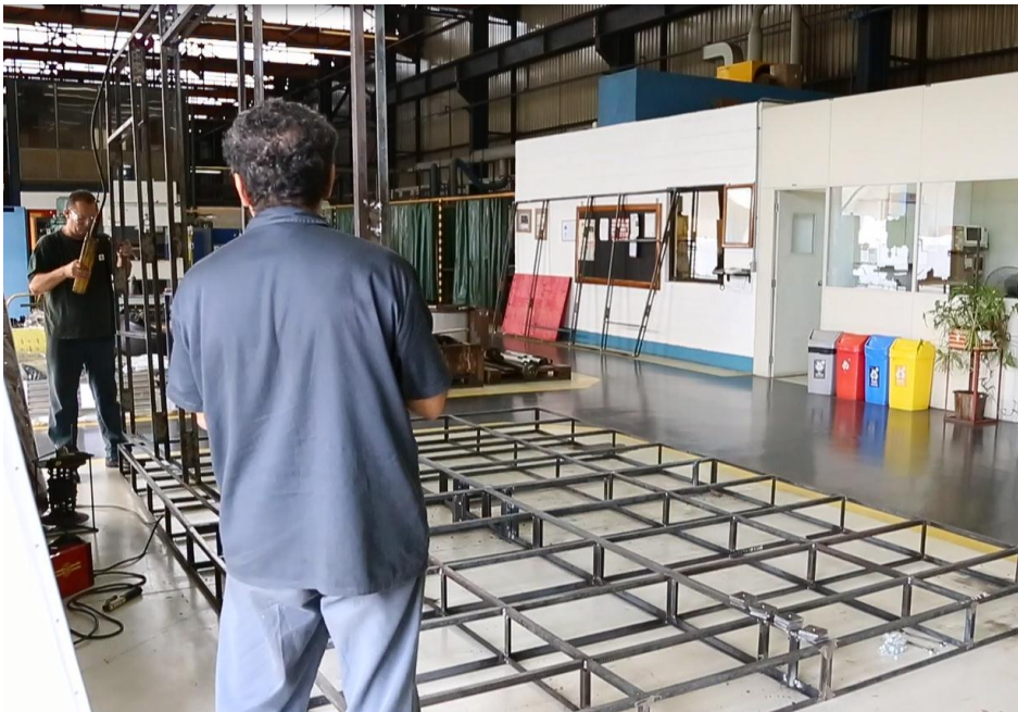
Figura 6 – Montagem da estrutura em Oficina
