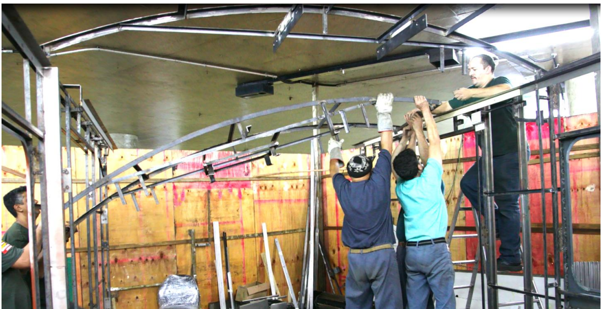
Figura 12 – Montagem da estrutura do teto
