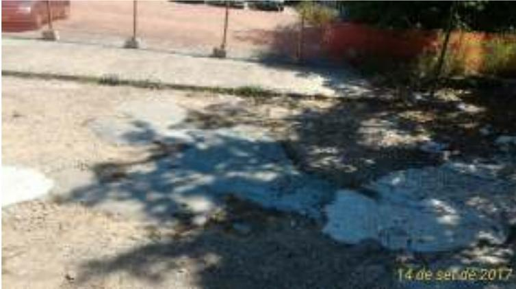
Figura 22 - Vazamentos CCPH na região de baixa cobertura isolada
