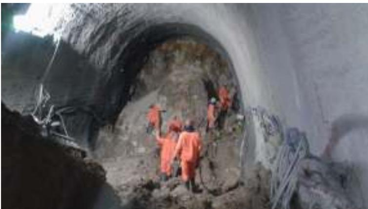
Figura 2 - Escavação do Túnel Singelo na região de baixa cobertura
