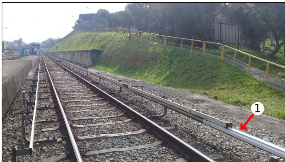
Figura 3 - Terceiro trilho (1) instalado ao longo das via.
