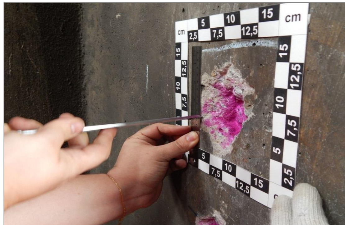
MEDIÇÃO DA PROFUNDIDADE DA FRENTE DE CARBONATAÇÃO COM PAQUÍMETRO E RÉGUA METÁLICA
