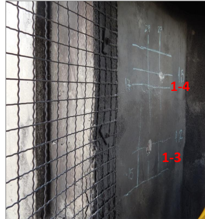
PONTOS DE ENSAIO REALIZADOS NA REGIÃO SUPERIOR DA TORRE DE VENTILAÇÃO
