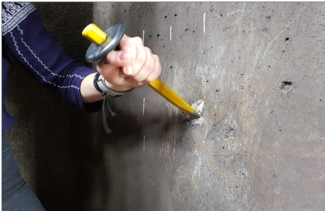
REMOÇÃO DO CONCRETO (MANUAL OU MECANICAMENTE) ATÉ A PROFUNDIDADE DA ARMADURA
