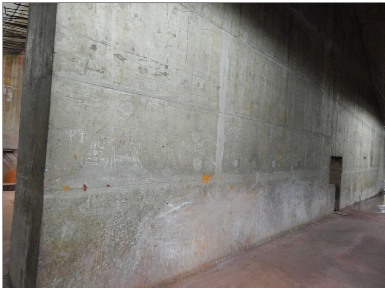
VISTA GERAL DA PAREDE ESCOLHIDA PARA ENSAIO
