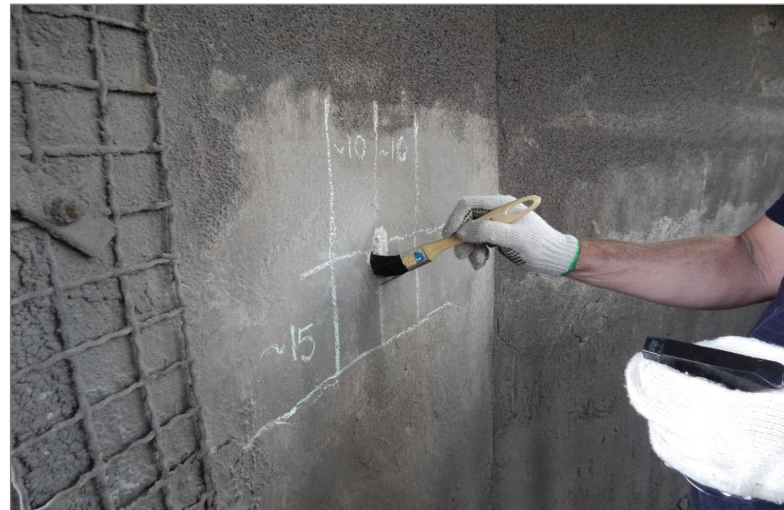
LIMPEZA DO CORTE COM PINCEL
