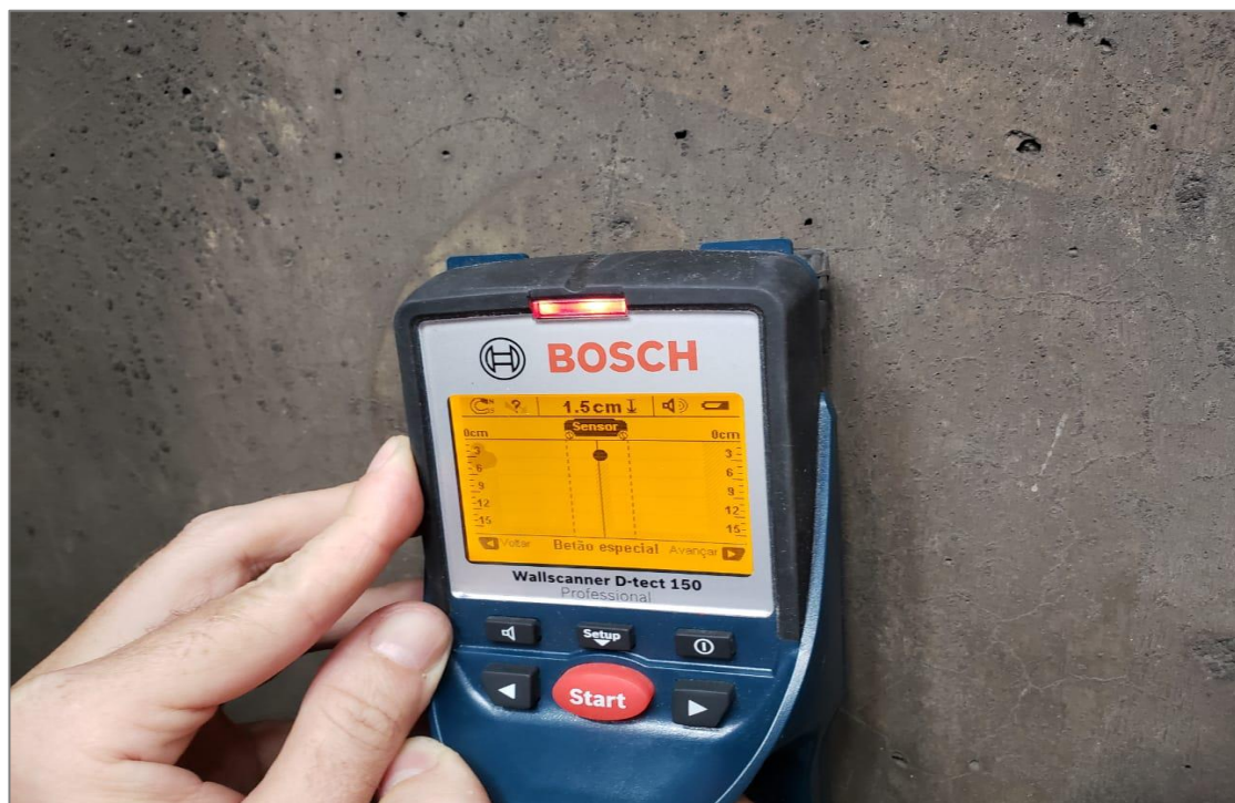
LIMPEZA DO LOCAL e DETECÇÃO DAS ARMADURAS
